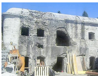
Il cantiere per i lavori di sistemazione del forte
